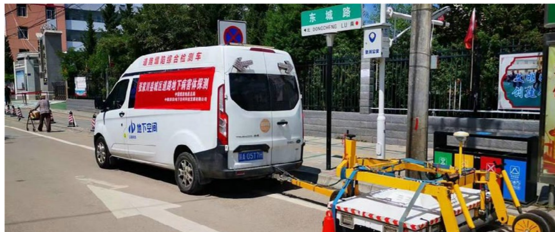
总局地下空间公司赶在汛期前赴张家川县摸排探查道路地下病害体，进行科技帮扶。
