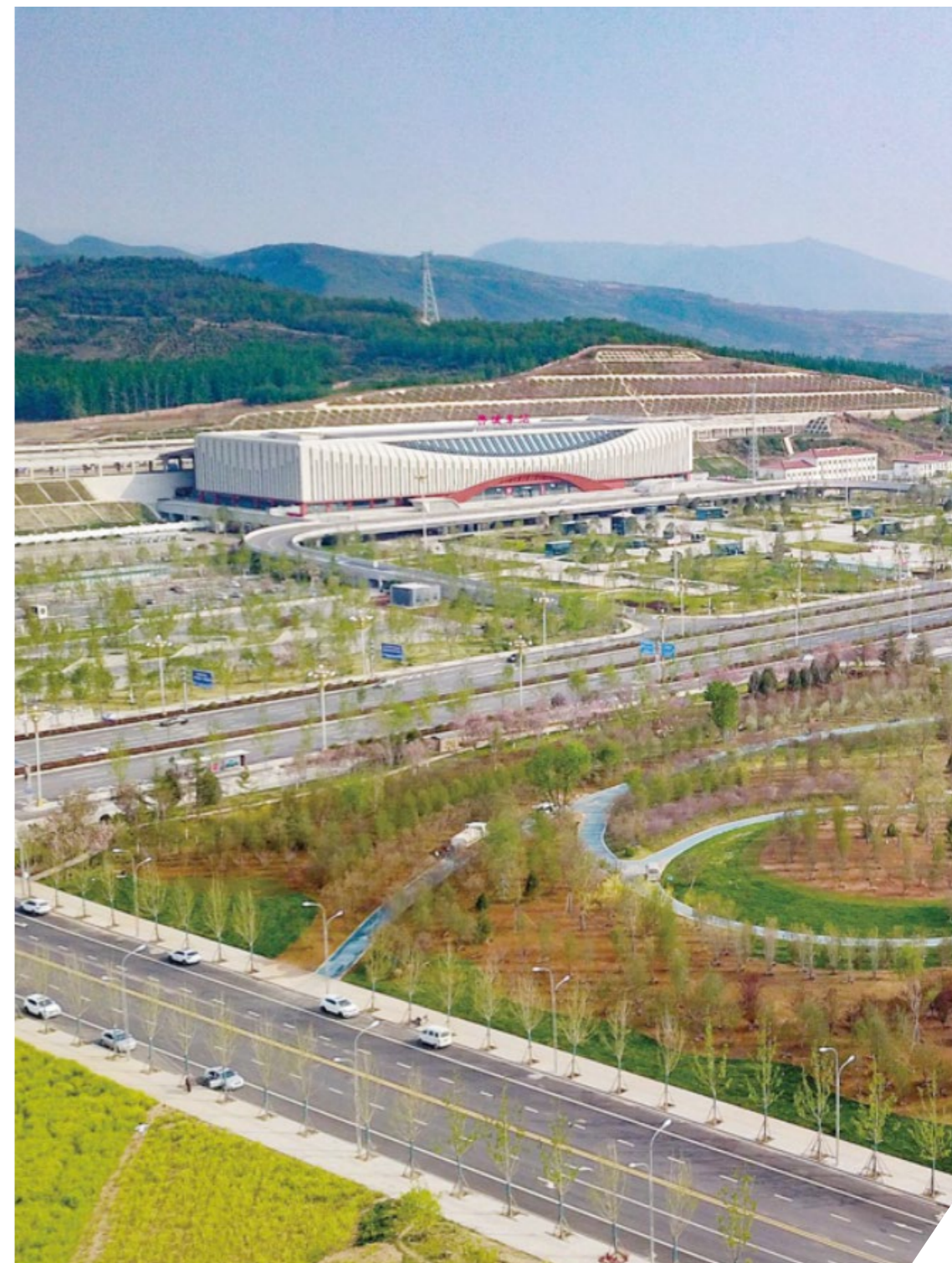
高铁晋城东站废弃矿山地质环境综合治理项目。
