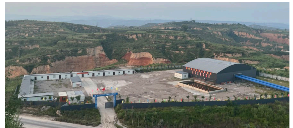
山西焦煤屯兰矿离层注浆控制采空塌陷项目。
