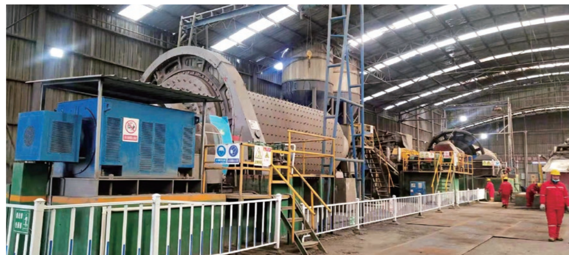
门克庆煤矿 3101 工作面采动覆岩离层注浆工程。
