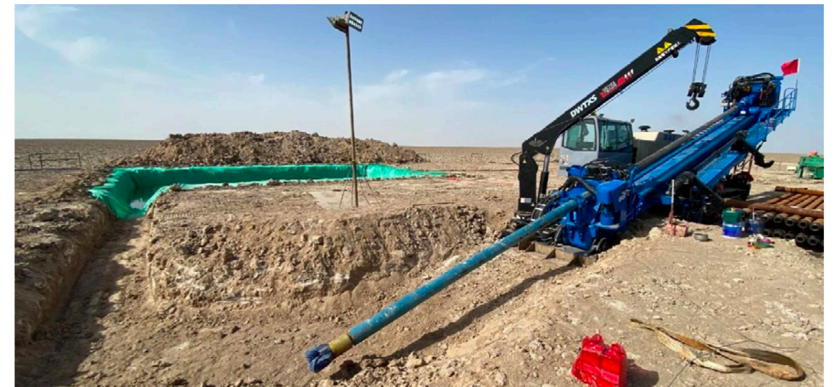
国投罗钾公司水平与竖井联合采卤工艺研究试验工程。
